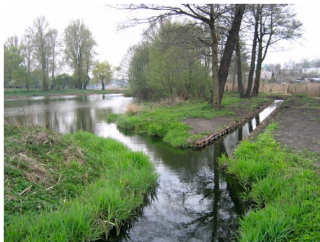
Rów opaskowy przy stawie retencyjnym
